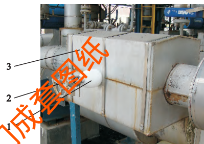
1. 填料函外部(结冰) 2. 阀门 3. 阀门壳体冷箱 图 7 某 LNG 接收站低温阀门
